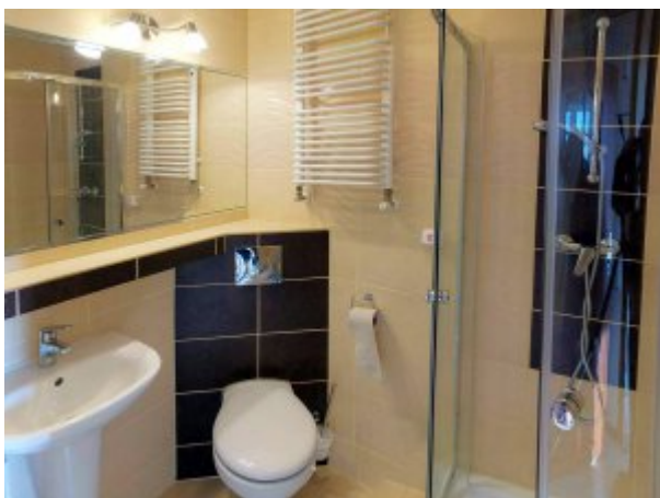
Węzeł sanitarny w pokoju jednoosobowym, fot. SP
