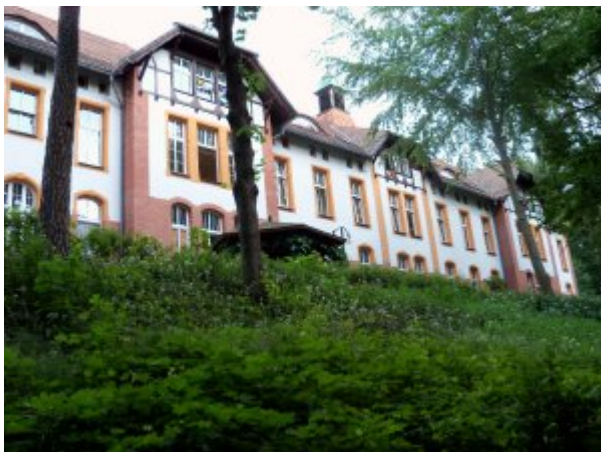
Budynek szpitala #1, fot. SP ZOZ Szpital Specjalistyczny MSW w Złocieńcu
