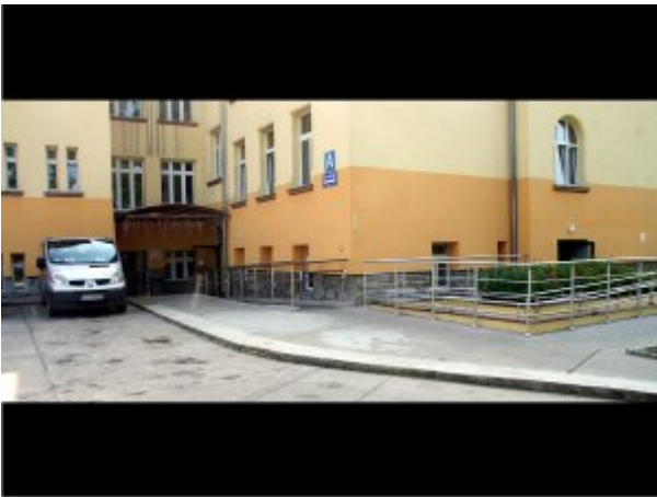
Budynek Oddziału Leczenia Nerwic oraz Poradni Logopedycznej, fot. SP ZOZ Szpital Specjalistyczny MSW w Jeleniej Górze
