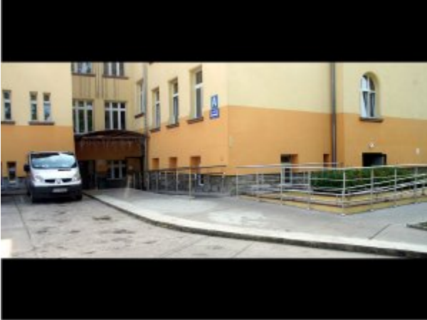
Budynek Oddziału Leczenia Nerwic oraz Poradni Logopedycznej, fot. SP ZOZ Szpital Specjalistyczny MSW w Jeleniej Górze
